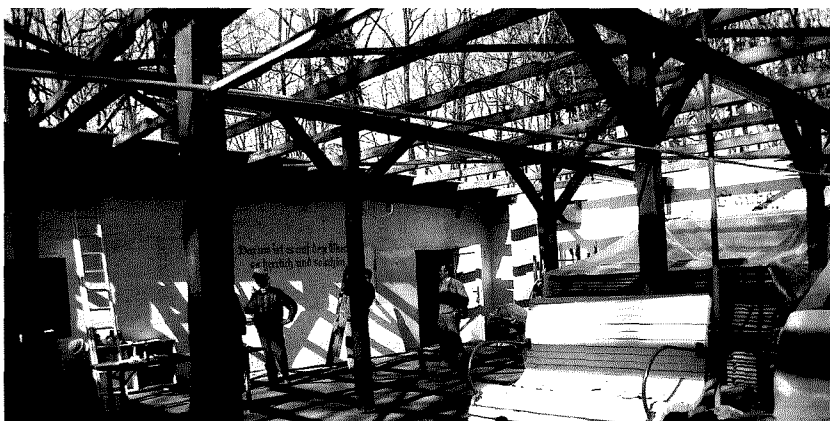
Das Dach ist ab
